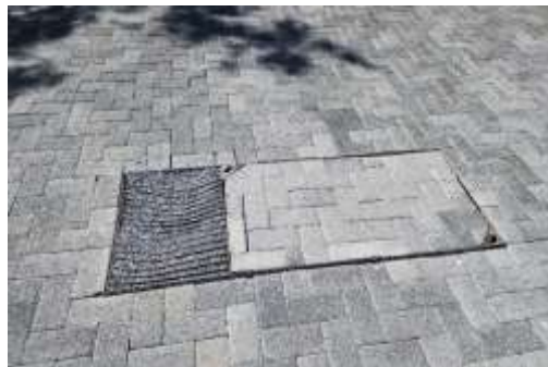
ภาพที่ 14 บ่อหน่วงน้ำเพื่อชะลอการไหลของน้ำส่วนเกิน
