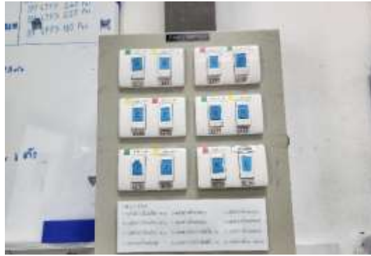
ภาพที่ 24 การแยกสวิตช์ควบคุมอุปกรณ์ไฟฟ้าแสงสว่าง
